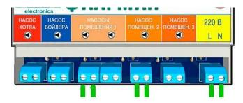
Выставляем на комнатных термостатах заданную температуру на каждом этаже, подключаем питание контроллера «220 В» соблюдая «L и N», и все заработает.
